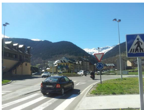
Figura 4.9. Rotonda carretera N-230 d'accés al nucli
